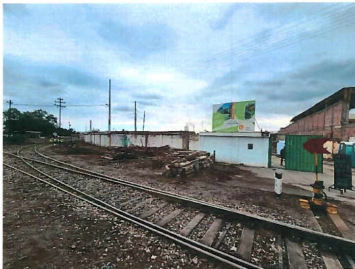
Figura N°05 – Delimitación de área concesionada con material de tercera (durmientes bi-block).
